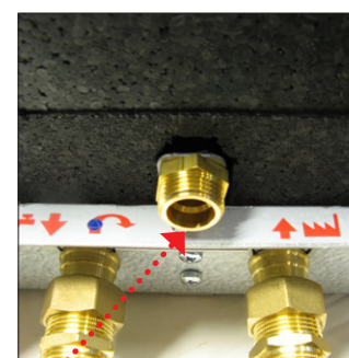
Соединение циркуляционных труб
